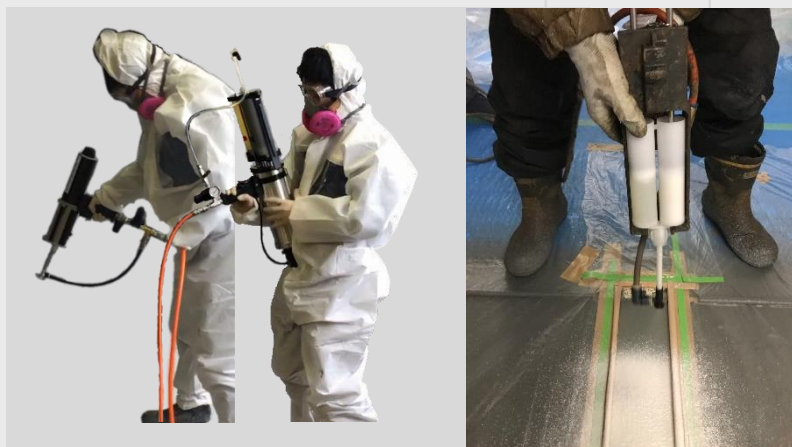
200ml カートリッジガン (写真左) 1500ml カートリッジガン (写真右)
